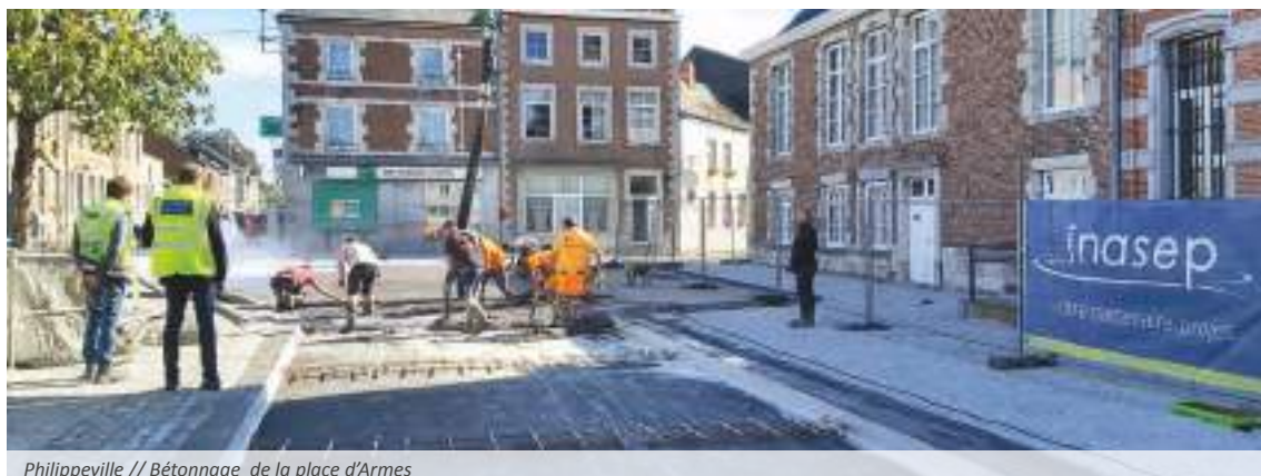
Philippeville // Bétonnage de la place d'Armes
