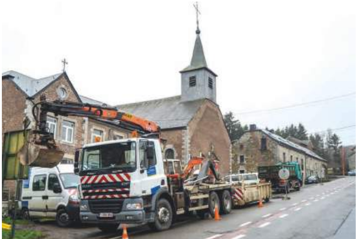
Intervention pour un nouveau raccordement
