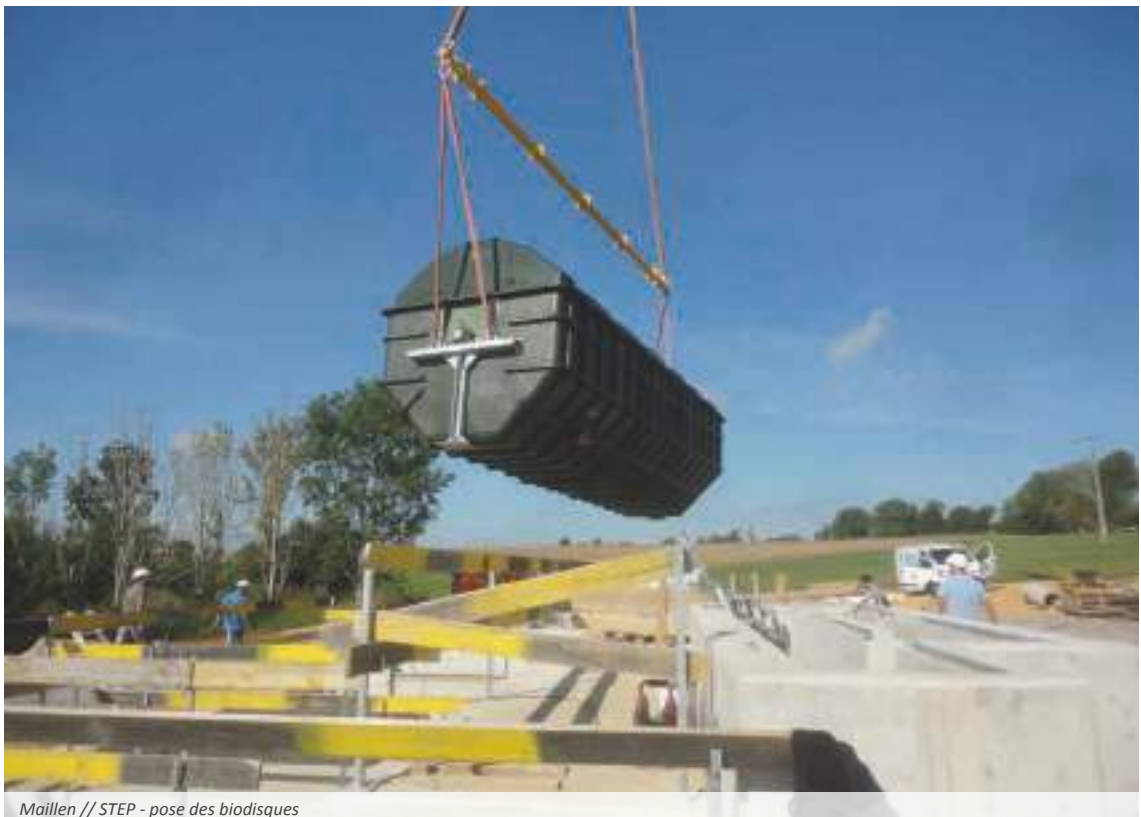
Maillen // STEP - pose des biodisques
