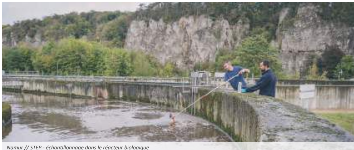
Namur // STEP - échantillonnage dans le réacteur biologique
