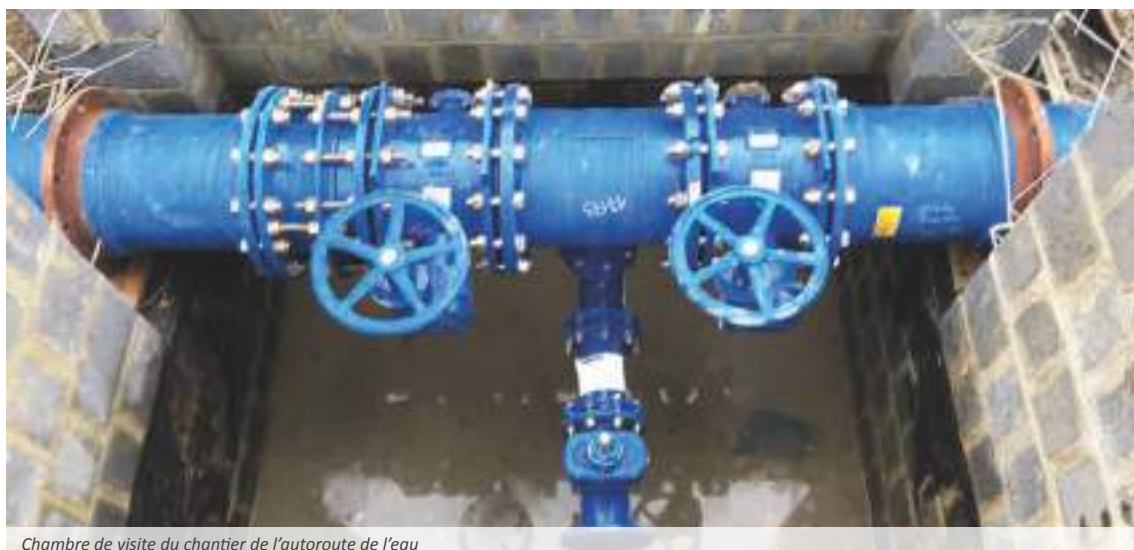
Chambre de visite du chantier de l'autoroute de l'eau
