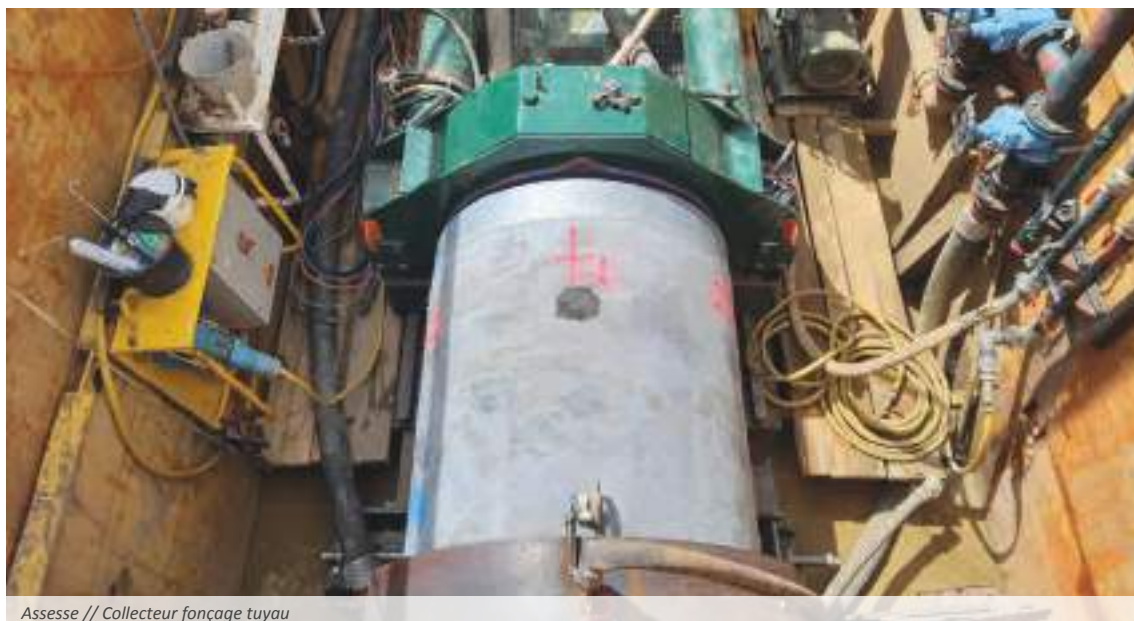
Assesse // Collecteur fonçage tuyau
