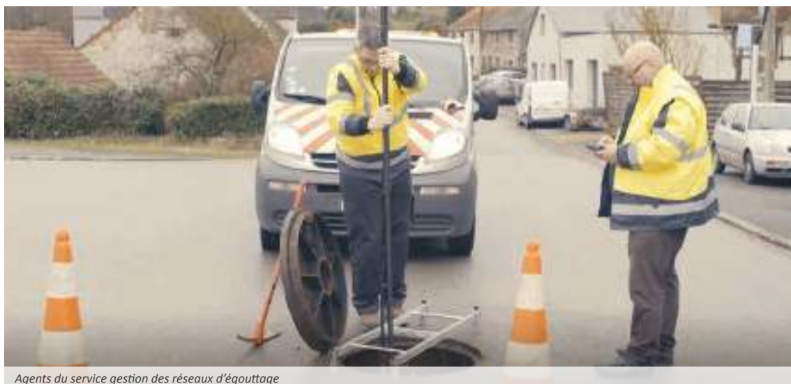
Agents du service gestion des réseaux d'égouttage
