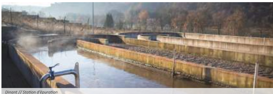
Dinant // Station d'épuration
