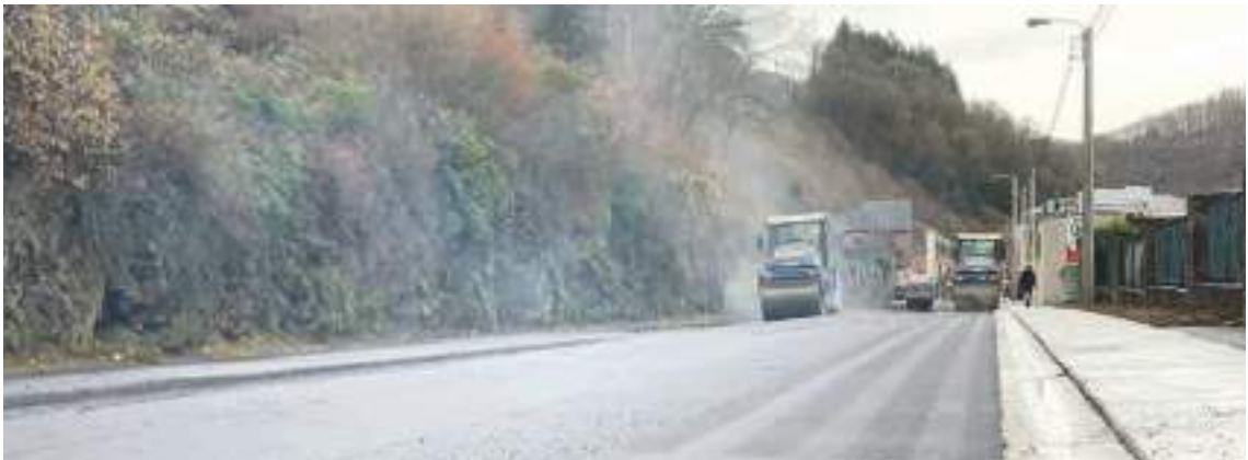
Hastière // Pose hydro 2 finisseuses
