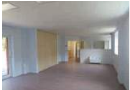
Gesves // Création d'une crèche à Sorée
