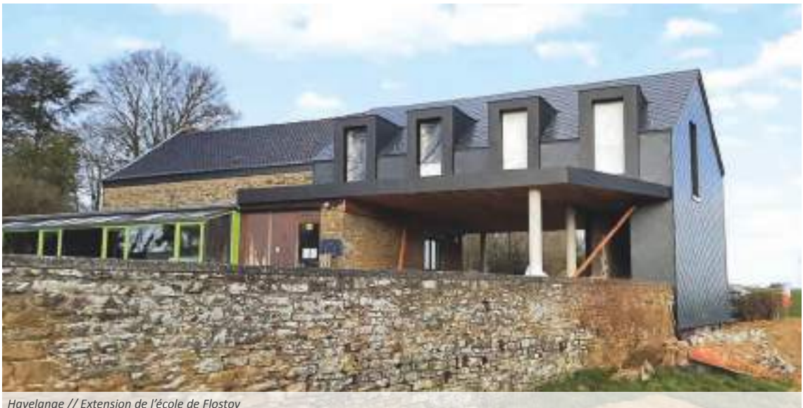
Havelange // Extension de l'école de Flostoy
