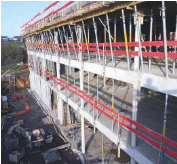
Dinant // Chantier du commissariat de la Zone de Police Haute-Meuse
