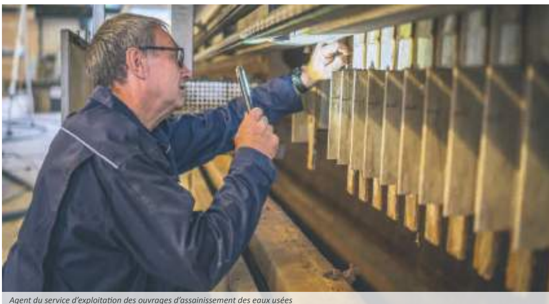
Agent du service d'exploitation des ouvrages d'assainissement des eaux usées
