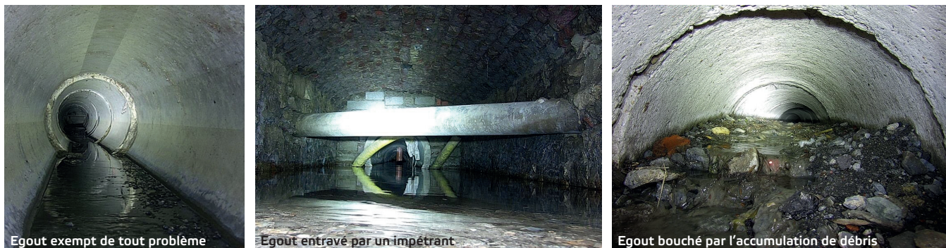
Egout exempt de tout problème
