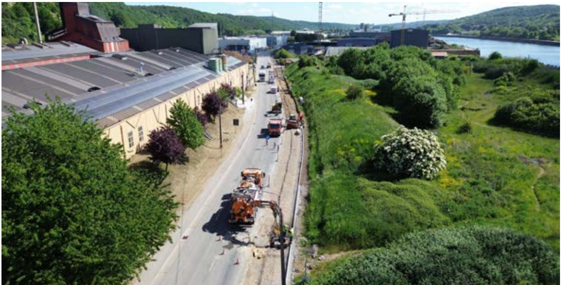
Andenne // Route industrielle
