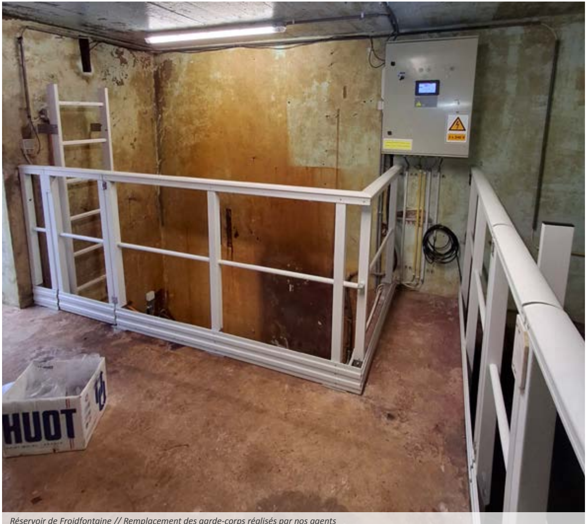
Réservoir de Froidfontaine // Remplacement des garde-corps réalisés par nos agents
