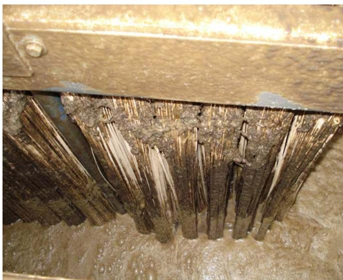
Vresse-sur-Semois // Remplacement des filtres à membranes d'ultrafiltration
